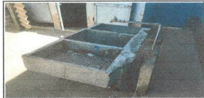
Foto No. 12: Sustitución de pla de cemento de dos lavaderos
