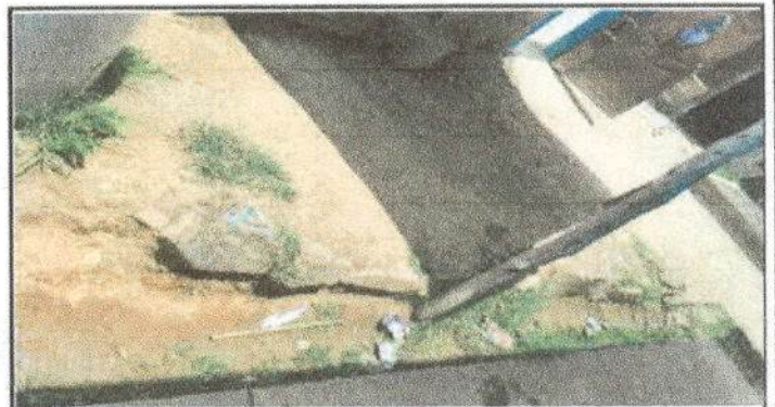
Foto No. 4: Sustitución de piso de torta de concreto
