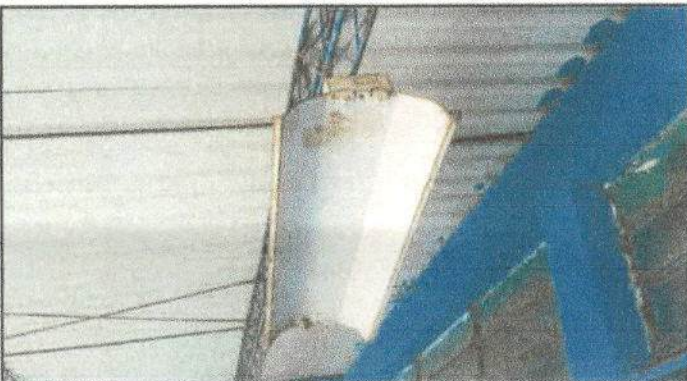
Foto No. 9: Sustitución de plafonas
