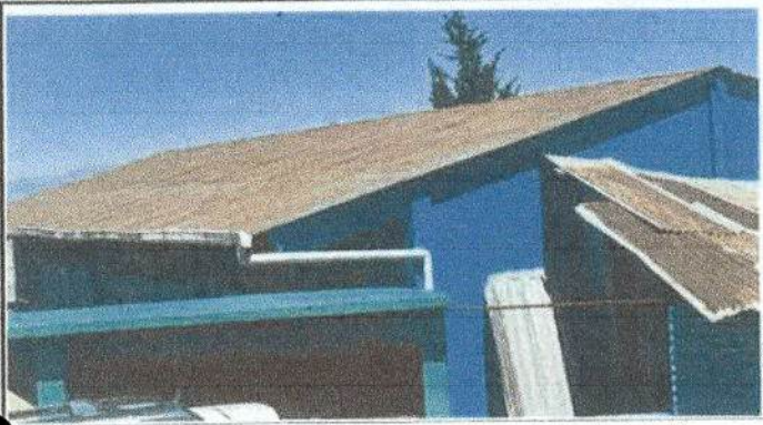
Foto No. 1: Sustitución de lámina por lámina troquelada aluzinc 26
