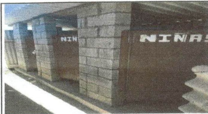
Foto No. 3: Sustitución de puertas en servicios sanitarios
